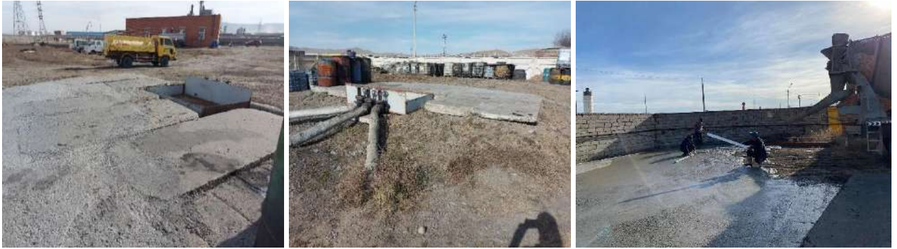
Зураг 17. Бетоны ажил
