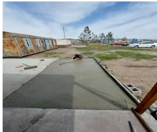
Зураг 5. Талбай бетондож буй ажлын явц
