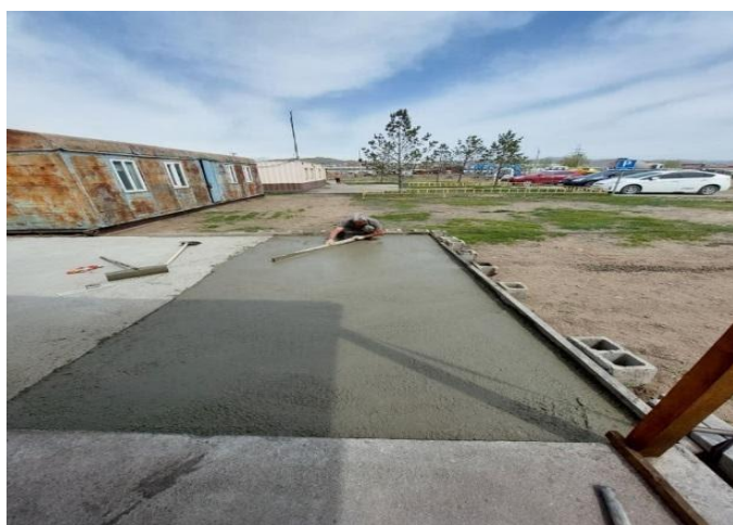
Зураг 5. Талбай бетондож буй ажлын явц
