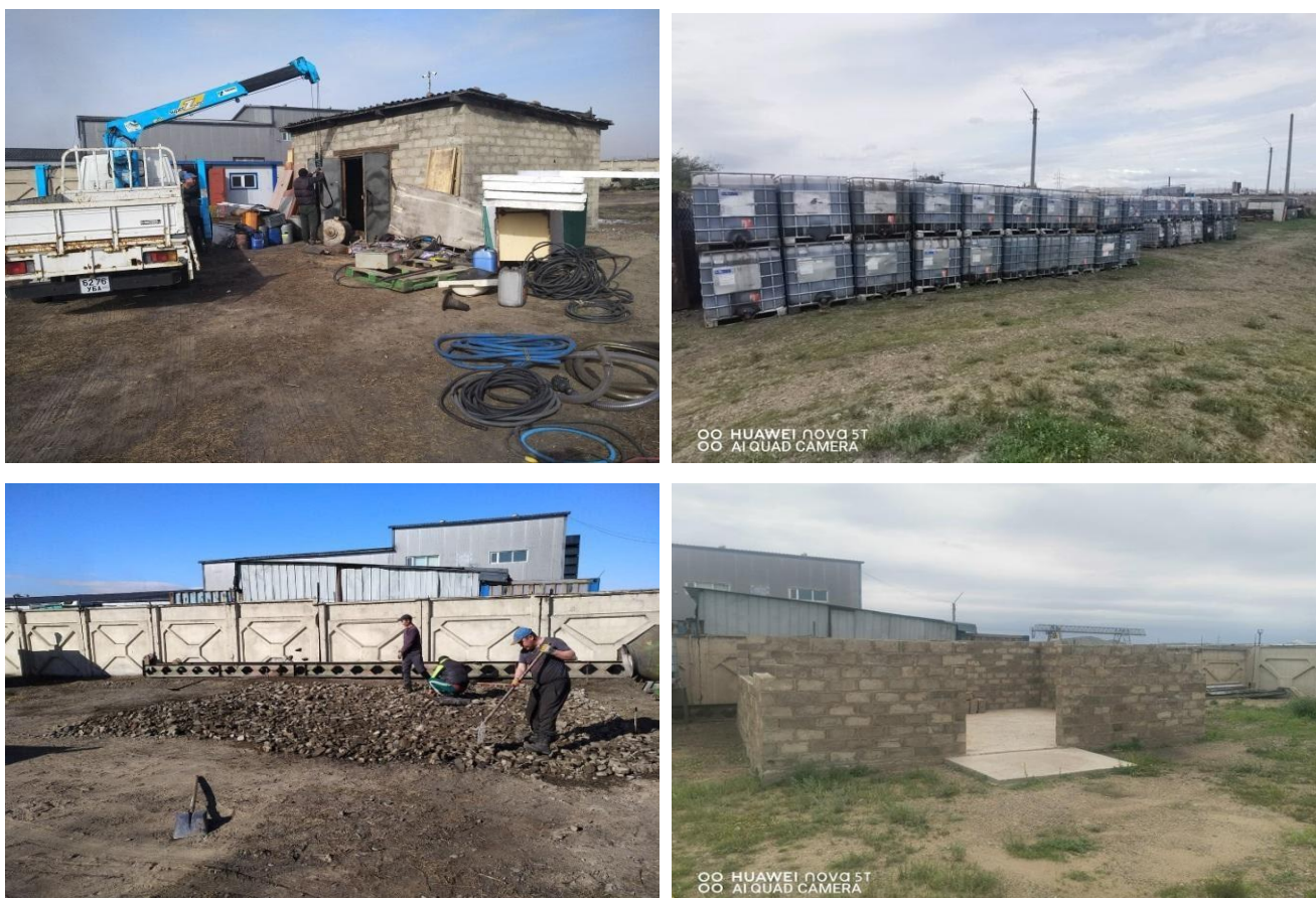
Зураг 8. Блокон барилгыг шилжүүлэн барьж буй ажлын явц
