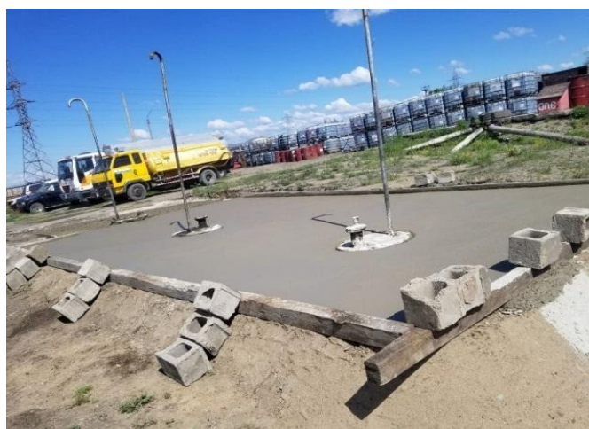
Зураг 5. Талбай бетондож буй ажлын явц
