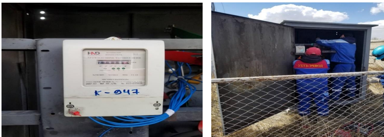
Зураг 6. Трансформаторын засвар үйлчилгээ
